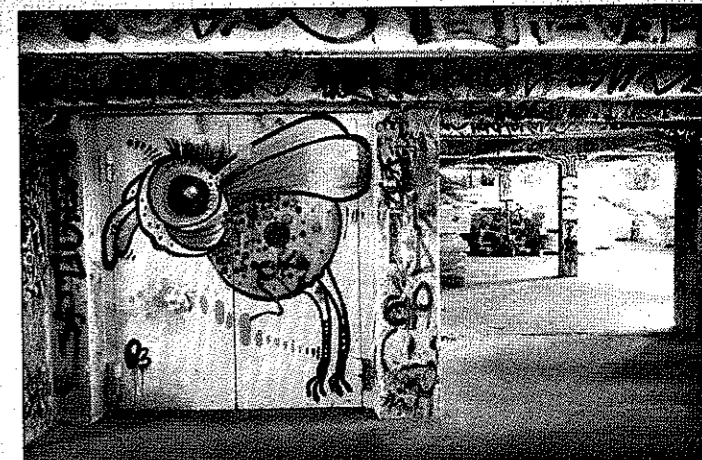
Ennen maalaamista rakennus on ollut lattiasta kattoon graffittien peittoissa.
